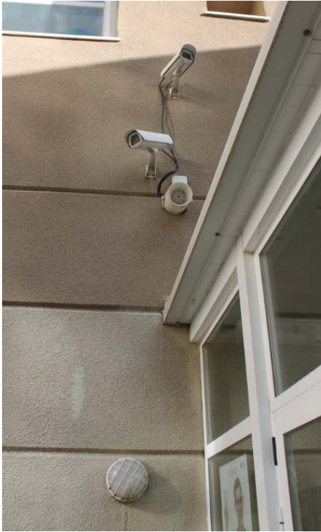
Cámara de vigilancia y plafón exterior a desmotar junto al vestíbulo de acceso.
