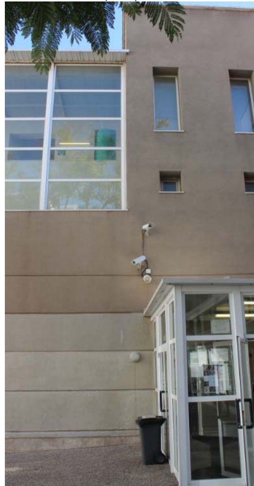
Vista general desde el patio de zona afectada por la instalación del ascensor.
