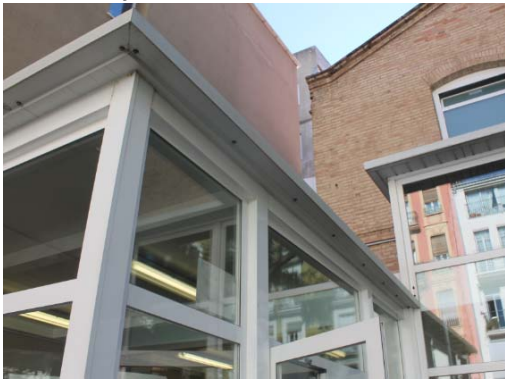
Detalle cubierta vestíbulo.
