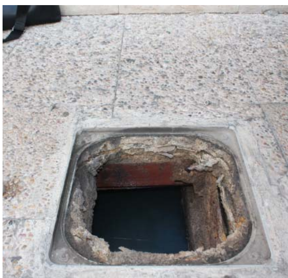
Arqueta Saneamiento Junto fachada.
