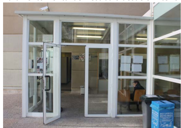
Paramento lateral del vestíbulo desde el exterior. Zona inalterada.
