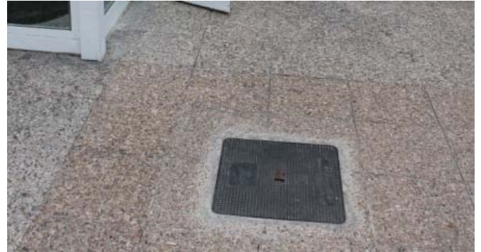
Arqueta de saneamiento junto al vestíbulo.
