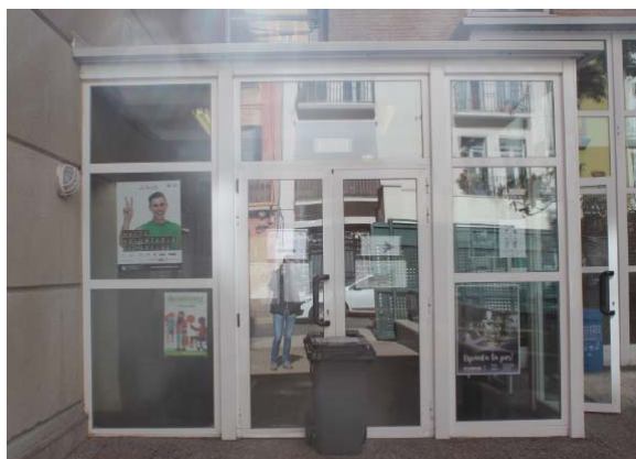
Paramento frontal del vestíbulo desde el exterior. Zona a desmontar.
