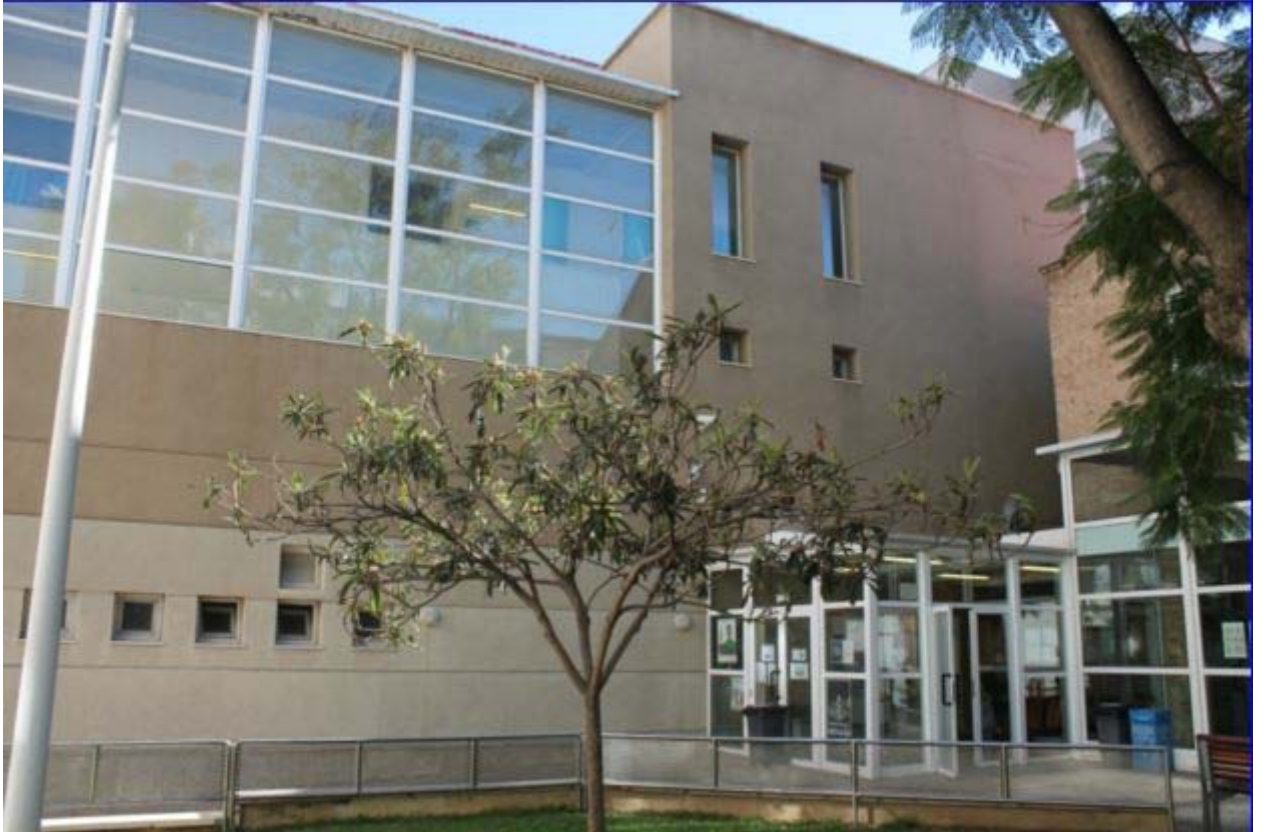
Fotografías del estado actual del edificio, ámbito de actuación.
