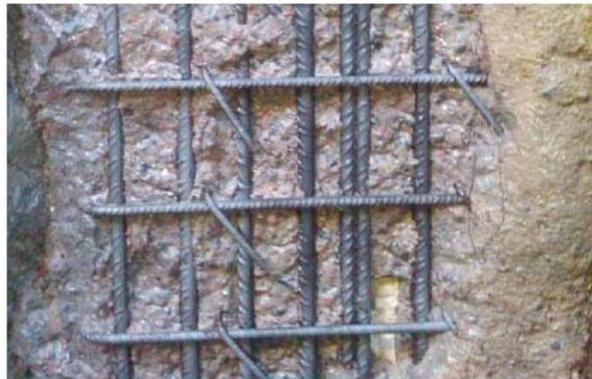
Protección contra corrosión de armaduras de acero en el sistema de reparación Morcemrest según la EN 1504-7. Puede ser usado en combinación con todos los morteros de reparación de la gama Morcemrest.
