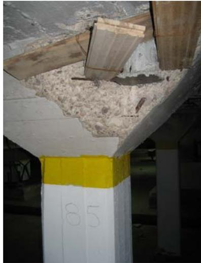
Continuamos con la inspección de los pilares que componen el sótano y pasamos a la zona de una altura inferior, 1.68 m., y con unos pilares cortos de dimensiones mayores, entre 60x60 cm y 50x50cm, con vigas de apoyo de gran sección que los unen en toda su longitud y que terminan con una viga en voladizo de 1,60 cm hasta llegar a la junta de dilatación transversal.
