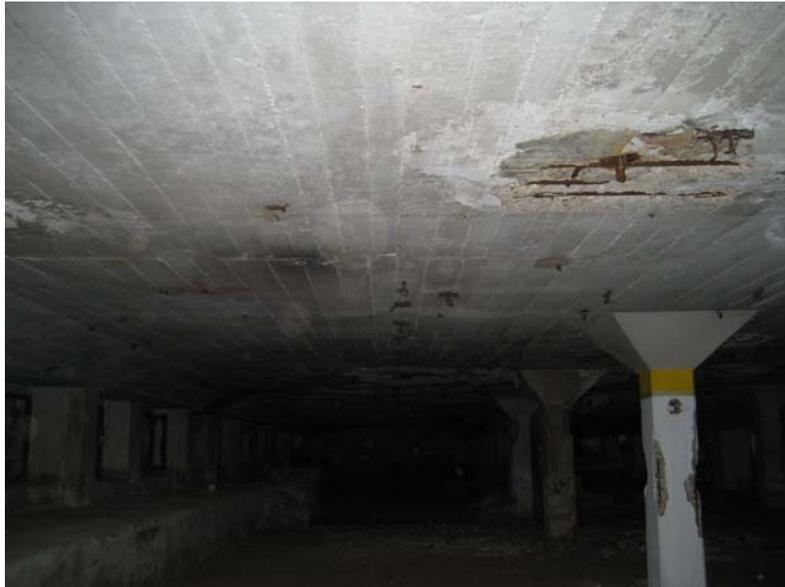
En la zona derecha, en el vano pegado a fachada y en casi toda su longitud, es la más afectada. Oxidaciones que han llegado a mermar la sección de las barras que conforman el armado inferior de la losa, con desprendimiento de su revestimiento y daños múltiples en toda su extensión.
