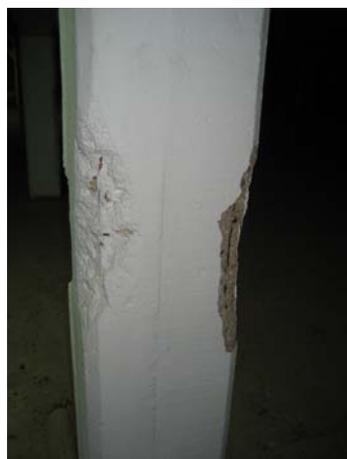
Se aprecia las barras que conforman la estructura vertical del pilar en esas esquinas, redondos del 12.
