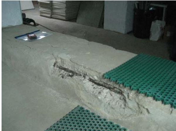
Grietas horizontales en toda su longitud, marcando la barra de montaje y hasta llegar a los pilares. Sin llegar a desprenderse pero como elemento suelto y a sanear.
