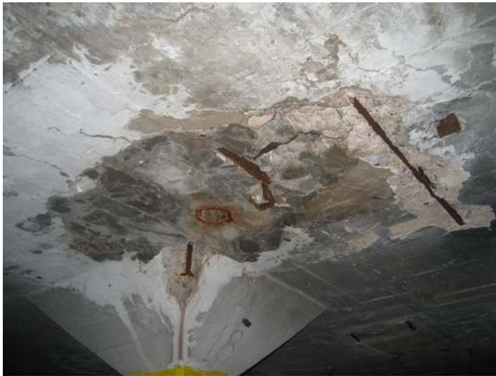
También existen daños generalizados de distinta extensión. Misma casuística, con desprendimiento de armaduras debido a su oxidación y a su escaso recubrimiento y paso de postes metálicos a través del forjado
