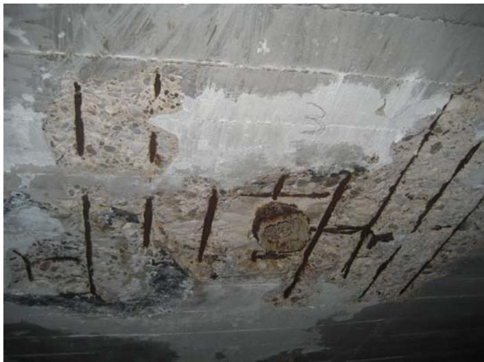
Múltiples anclajes metálicos de todo tipo de tuberías o elementos colgados que siguen produciendo daños en la losa por su oxidación continuada. Se observan efectos puntuales y de distinta extensión en la oxidación del armado inferior de la losa.
