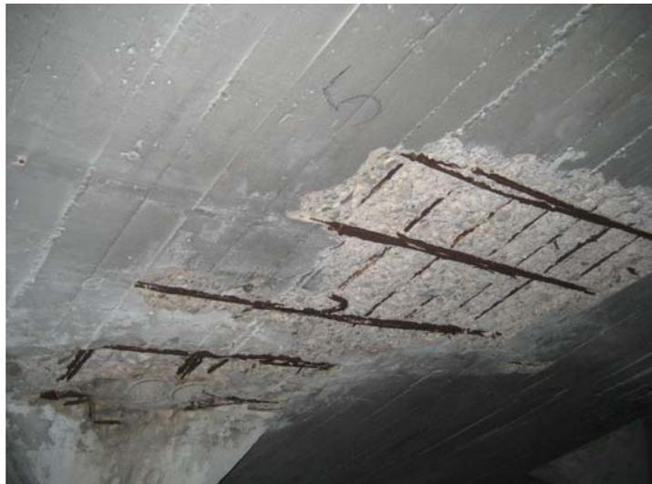
**2.2. Análisis de la patología – corrosión de las armaduras**
