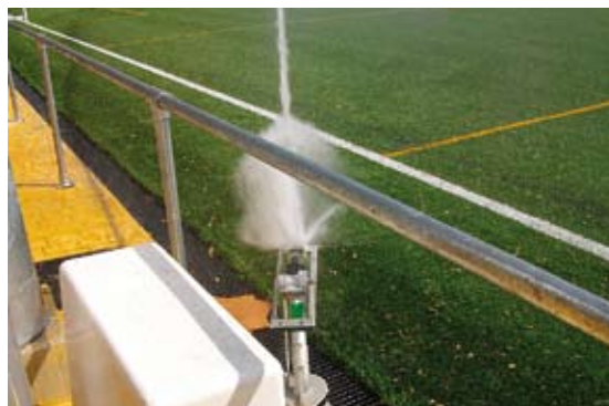
Detalle de cañón y rotura de chorro.
