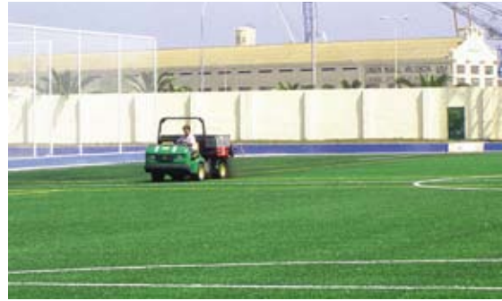
Recebo de caucho con máquina dosificadora.
