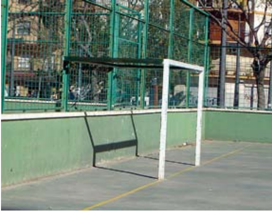
Anclaje antivuelco de portería de exterior.
