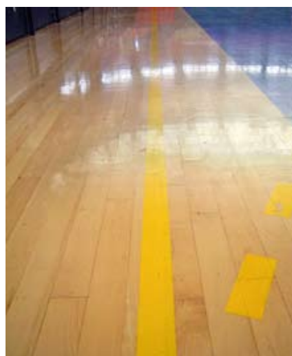
Tarima de madera barnizada.
