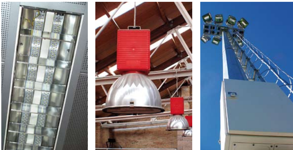
De izquierda a derecha: Lámpara LED formato fluorescente, proyector campana y torre de iluminación con cuadro.
