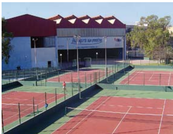
Pistas de Tenis de hormigón poroso.
