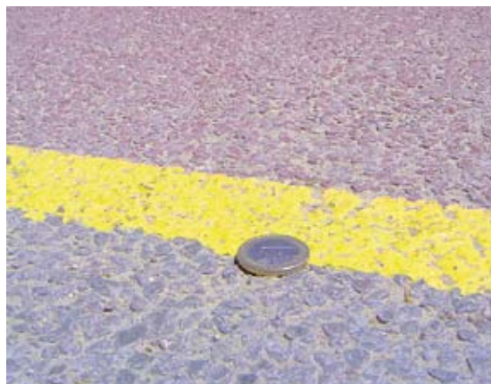
Detalle de hormigón poroso.
